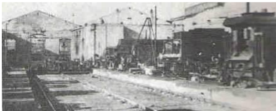
Warsztaty kolejowe, hala parowozowni.
