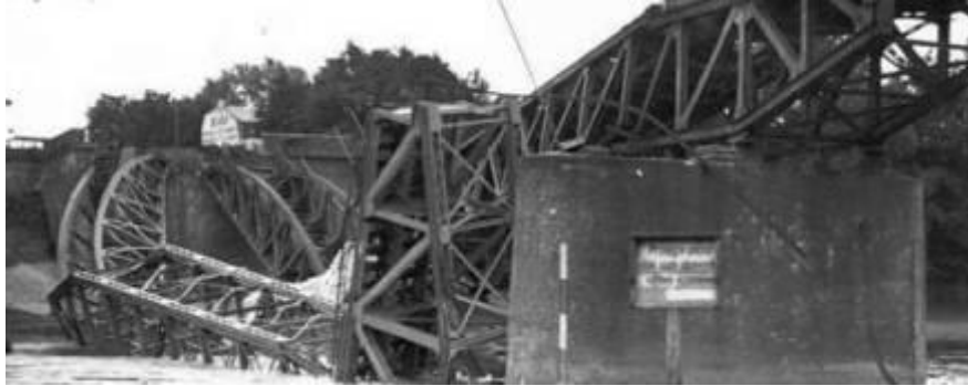
Most kolejowy Dębina –Starołęka
