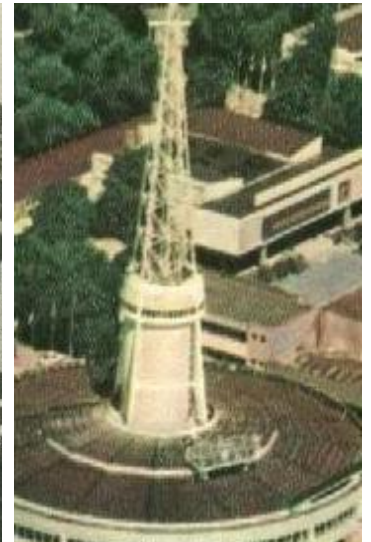
Po odbudowie, tzw. Iglica.
